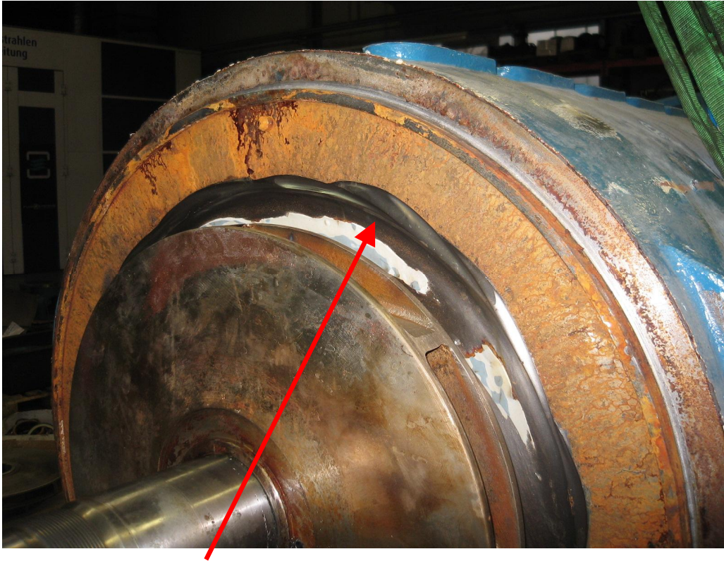
Ausspülung / Abrasionsverschleiß im Hydraulikteil
